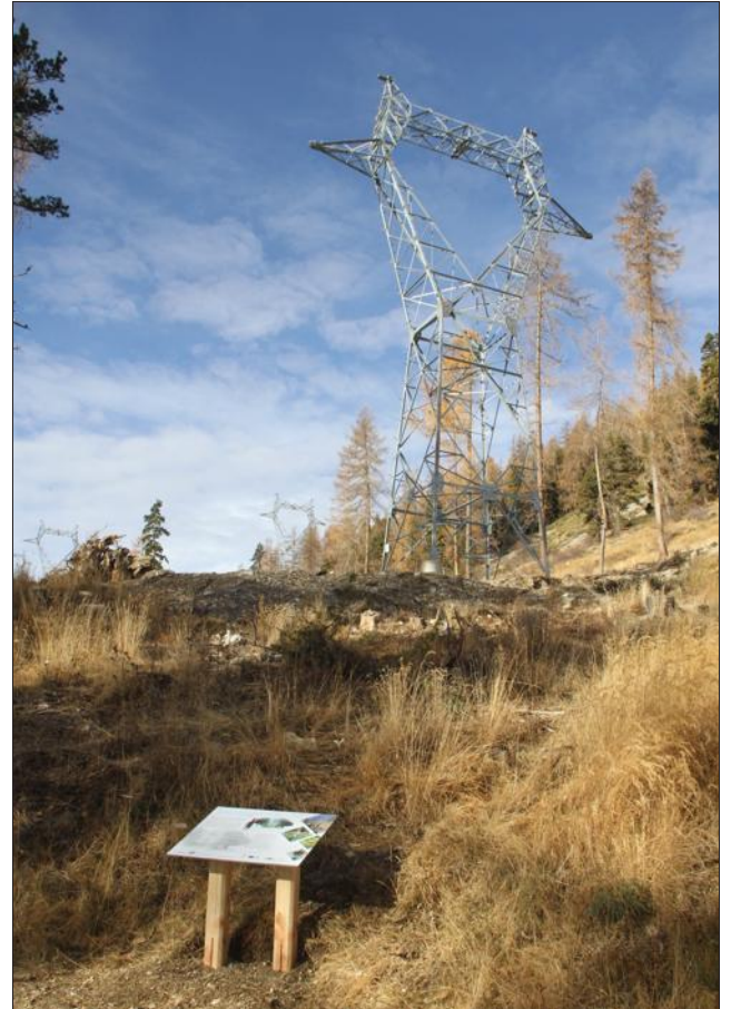
Des panneaux ont été installés pour informer le public.
