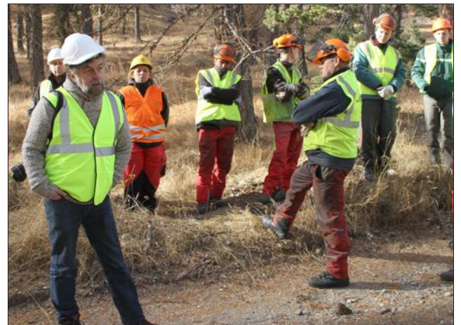
Gérard Jadoul (à gauche) est le responsable du projet Life Elia-RTE sur le chantier de la ligne Haute-Durance.
