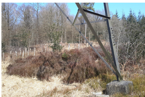
Plants de callunes semenciers à la base du pylône
