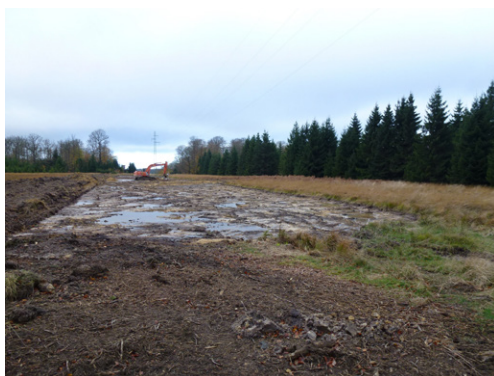
Exemple d'un étrépage sur une large zone, notez la présence d'eau en surface
